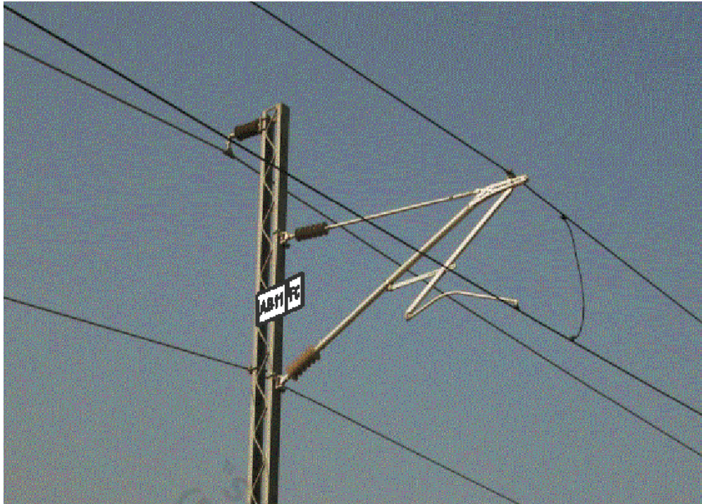
Fig. 4 - Targa identificazione sezioni linea di contatto applicata al sostegno
