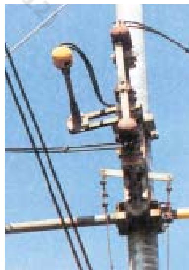
Figura 8: Commutatore in posizione di chiuso
